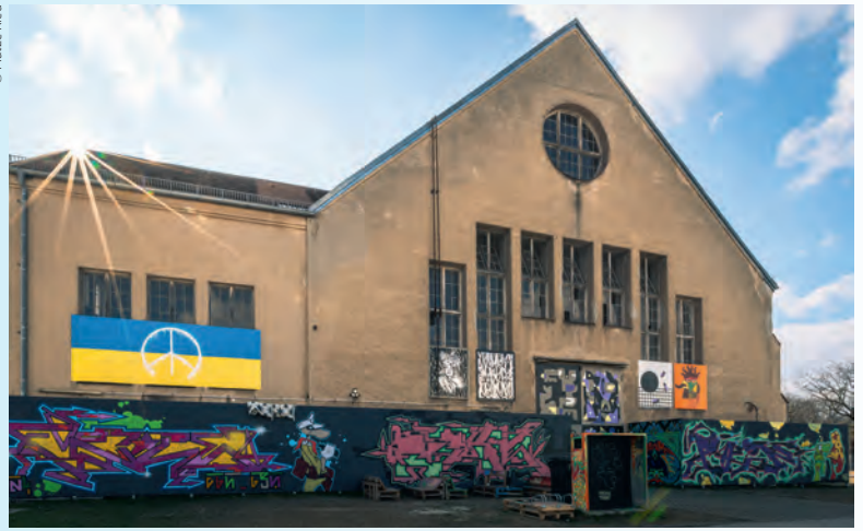
Das denkmalgeschützte Maschinenhaus in Schwabing-West
