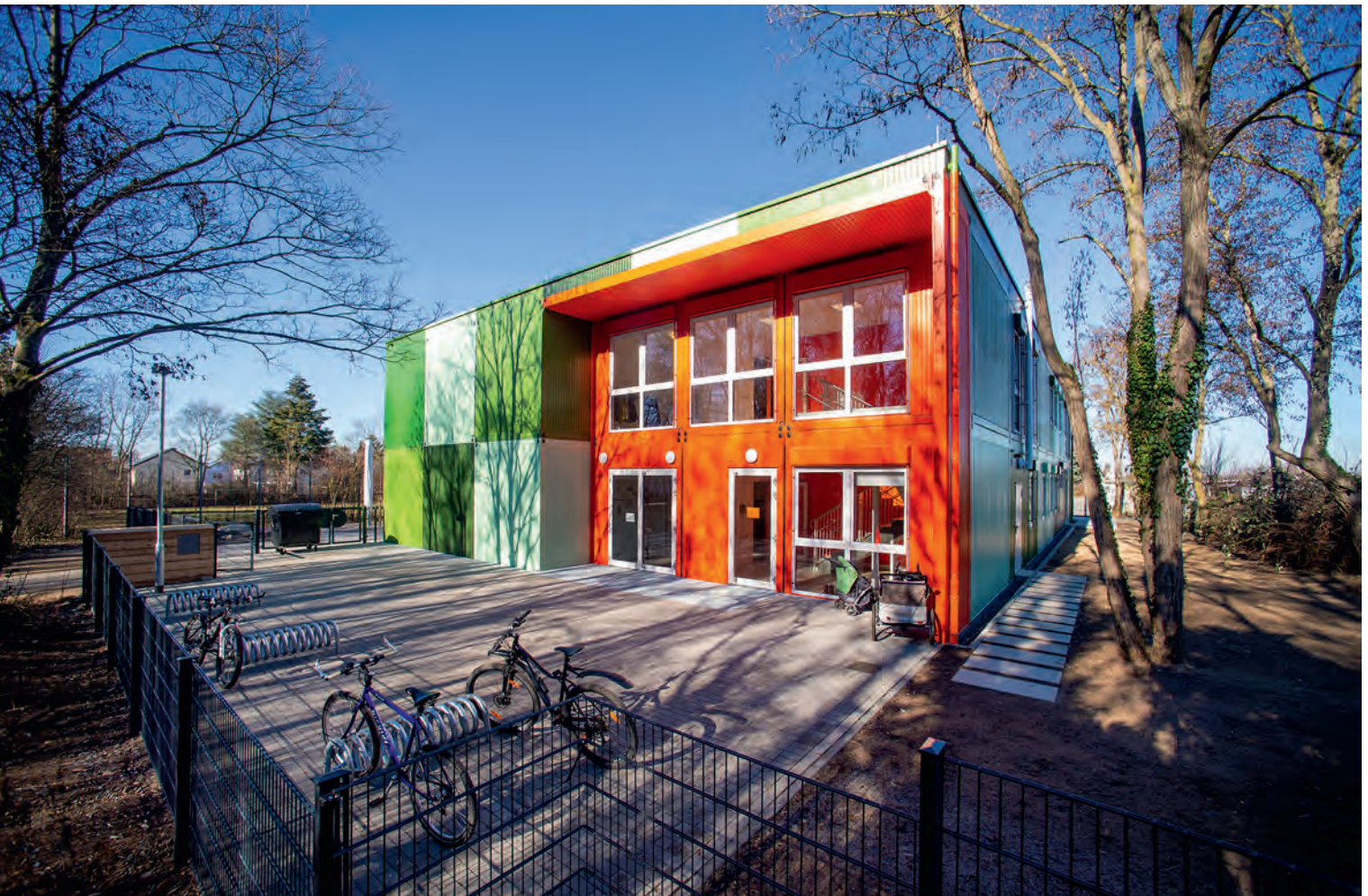
Modulare Kita in Darmstadt. Trendige Container-Architektur mit Wohlgefühlcharakter und moderner Technologie.
