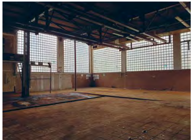
Im Inneren der „neuen“ Betriebshalle
