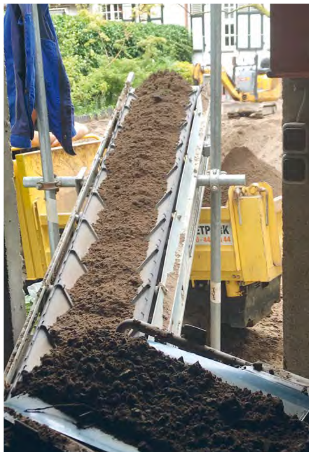
Eine besondere Herausforderung war der Bodentransport durch eine Garage mit einer schmalen Seitentür. Mit einem Förderband war auch dieses Grundstück innerhalb von zwei Wochen fertig.
