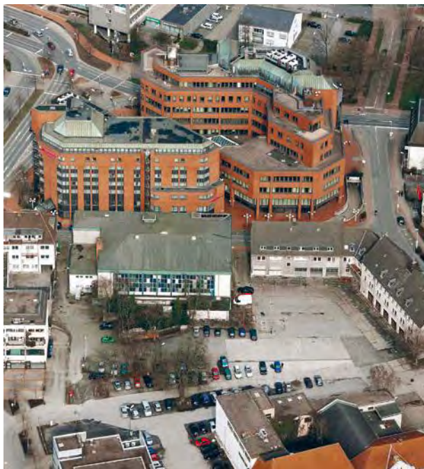
Das Areal vor der Sanierung
