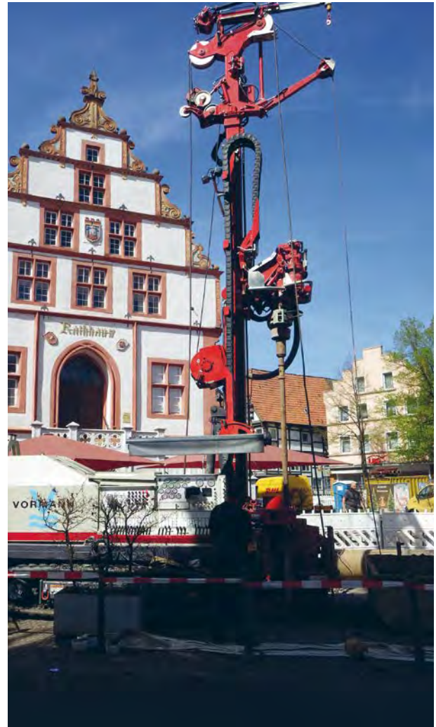
Bau Sanierungsbrunnen vor historischem Rathaus
