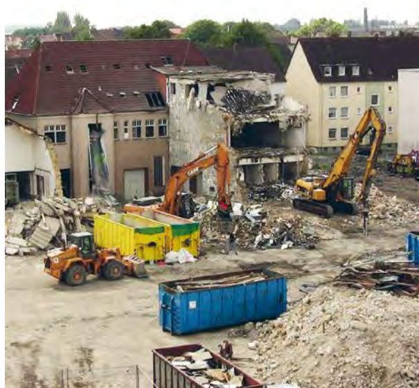
Rückbau der Gebäude
