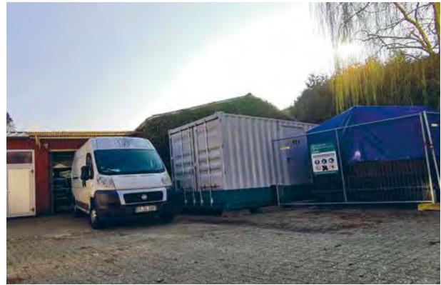
Standort der Sanierungsanlage mit Bioreaktor, Entnahmeeinheit und Vorlagenbehälter
