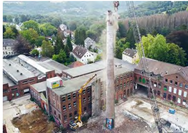
Der Kamin wurde mit einem Spezialbagger zurückgebaut
