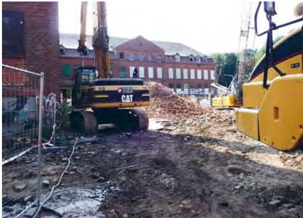
Gebäuderückbau vor der Bodensanierung
