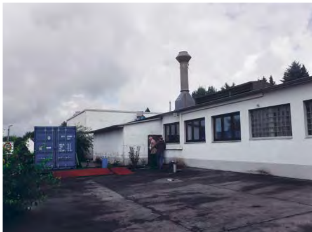
Betriebsgebäude mit Grundwassersicherungsanlage
