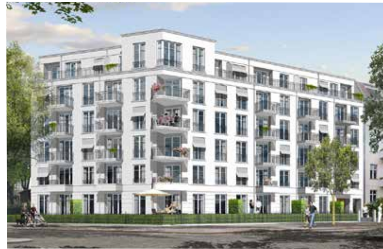
Projekt: Wohnungsbauprojekt „FriedrichsCarré“ Berlin-Pankow – Wohnungsbauprojekt Projektvolumen: 24 Wohnungen
